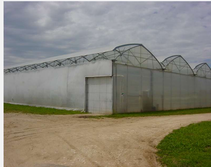
Multi chapelle double paroi
