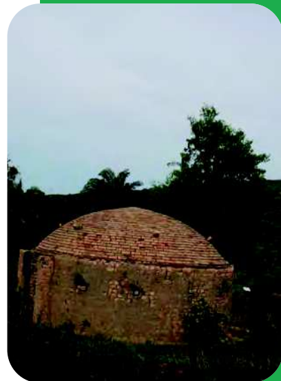
Four de carbonisation maçonné, République démocratique du Congo. © F. Pinta, Cirad
